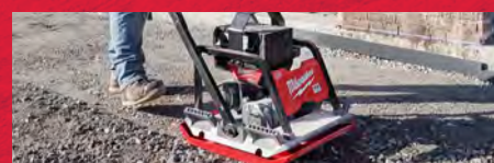
STEP 2 COMPATTAZIONE DEL SUOLO
